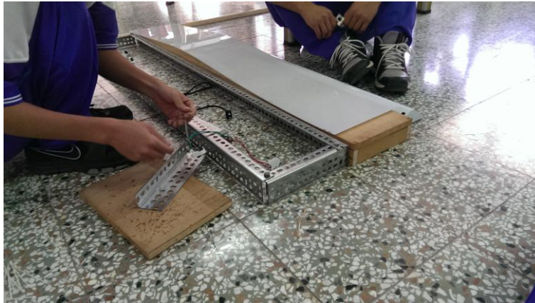
圖 8 LED 燈座配線
