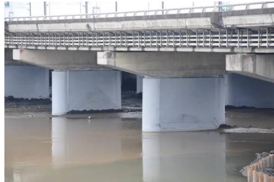
圖 3-5-9 蘭陽大橋橋墩
