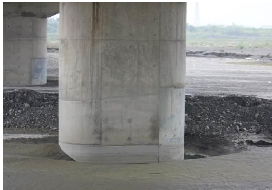
圖 3-5-8 葫蘆堵大橋橋墩
