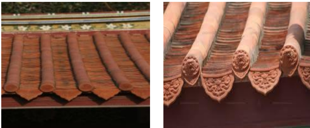
圖 1、屋頂排水板的溝槽結構
