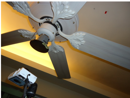
圖 49 全新吊扇安裝
