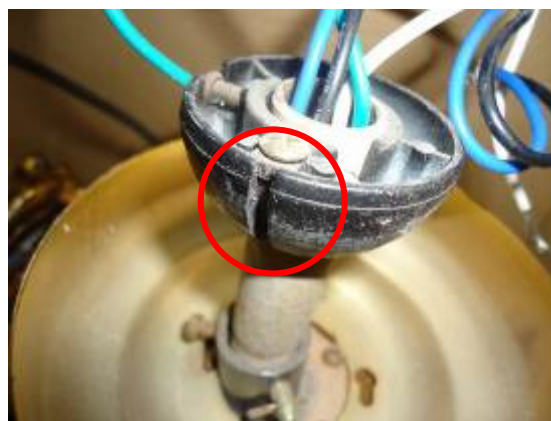
圖 67 吊扇吊桿上的球頭 (上方有凹槽)
