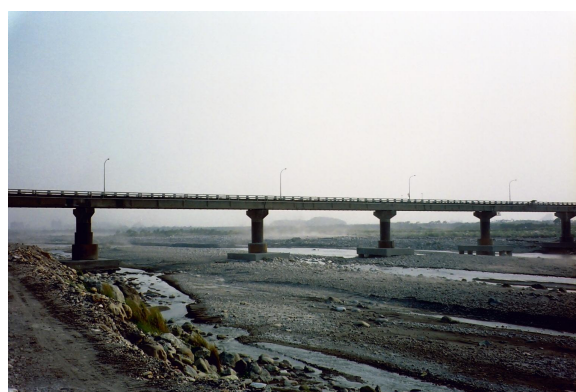
圖二 卑南溪河床沙塵滾滾(台東大橋)
