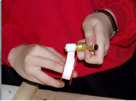
直角彎頭處須以止洩帶包紮以防止水流滲出
