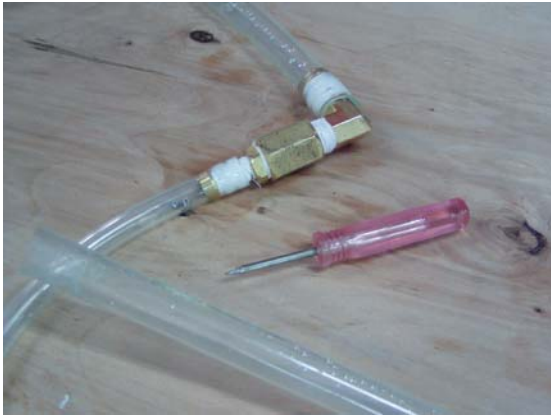
直角彎頭處須以止洩帶包紮以防止水流滲出
