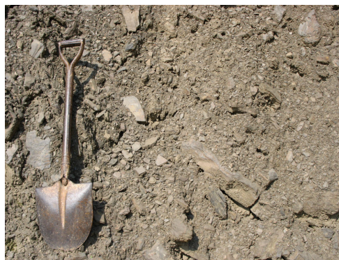
照片 14 泰武鄉山崩附近新開挖的路旁剖面可見疏鬆土石
