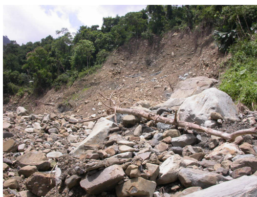
照片 16 六龜鄉土石流沿岸新的崩坍
