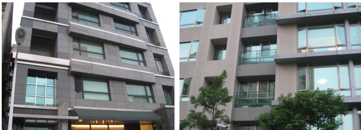
圖（ 21 ）依賴空調、技術先進的現代建築，大面積的開窗，該開口的部位卻用固定玻璃，不符合通風原則
