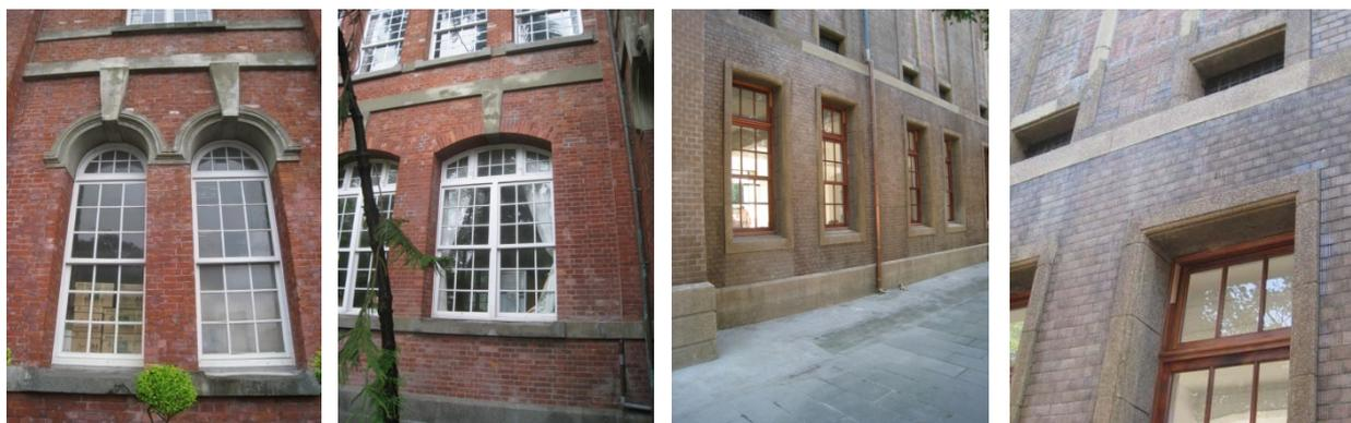
圖（ 20 ）無空調規畫又有結構及技術限制的老建築，都採用垂直向的三段式開窗，符合通風原則
