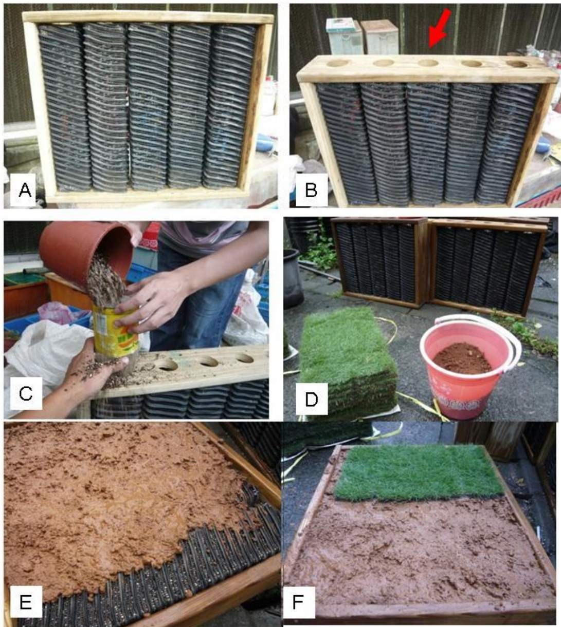
圖一、立體草牆的材料與製作說明。(A)PVC透水管與外部南方松木框，整體裝置高50cm*長50cm*寬10cm。(B)於整體裝置上方鑽孔(紅色箭頭處)，以便填入介質。(C)介質裝填情形。(D)裝填完成的框架，準備進行草皮黏著作業。(E)草皮黏著劑-陽明山土的鋪設狀況。(F)草皮鋪設時需緊密壓實，以利黏著。
